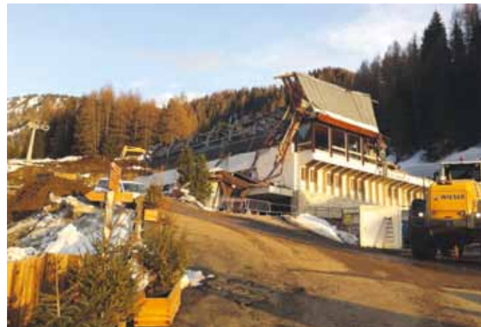
L'abbattimento della stazione a valle
