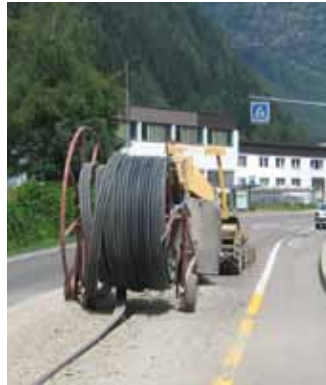
Rohre, Kabel, Knotenpunkt-Aufrüstung: Der Ausbau des Breitbandnetzes ist äußerst aufwändig
