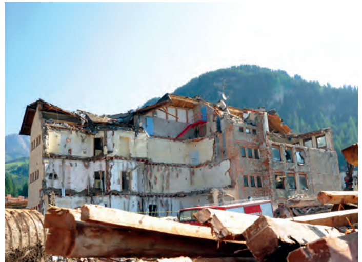
Die Hälfte des Schulgebäudes ist bereits abgerissen...
