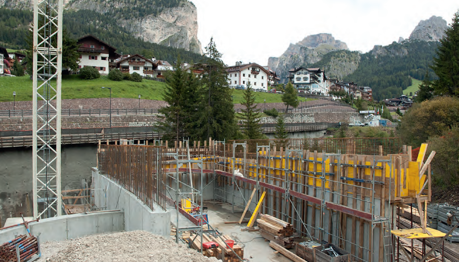
Lavori presso il ponte "La Sëlva"
