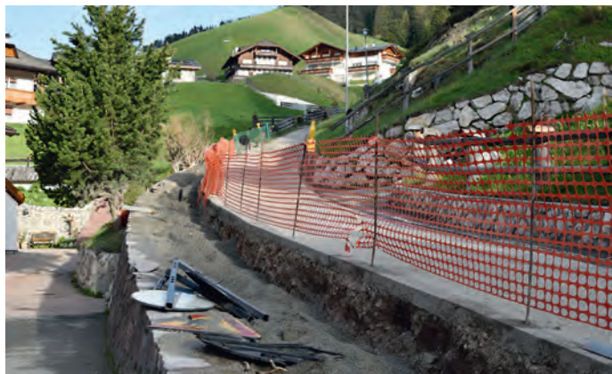
Sono iniziati i lavori presso il marciapiede nella frazione Daunëi
