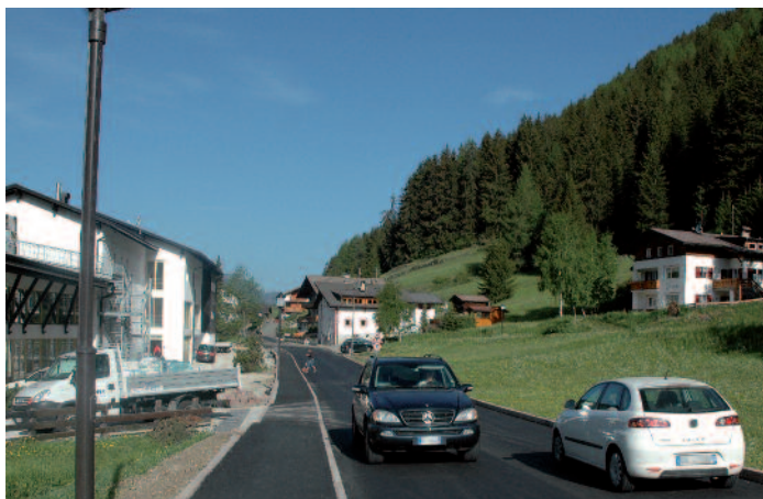
I lavori di allargamento del marciapiede in zona La Poza sono terminati
