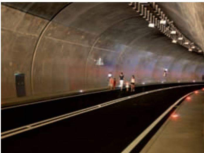
N l di dla giaurida pudoven jì, zënza trica, a pé tres l tunnel...
