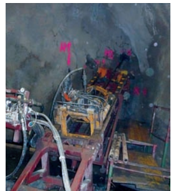
La mascin che fora i bujes che tol su l'ega; l tunel ie 275 metri lonch y 3-4 metri lerch.
