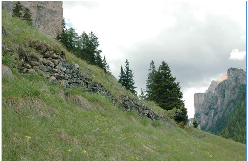
Muri a secco nella località "Cèdepuent – Curzelon"
