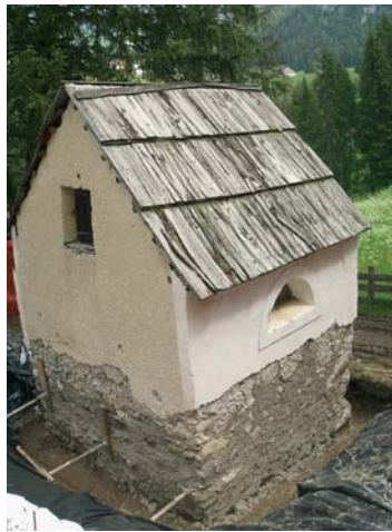
La fundamëntes vën scurides defin per na derturazion da fonz ora y per tò ora l' ega.
