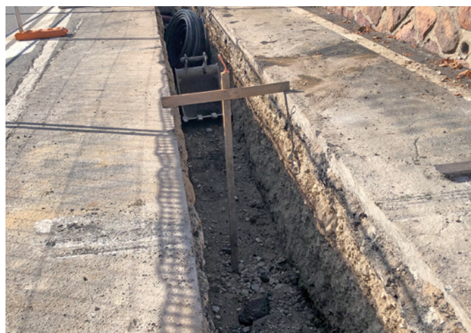
Lavori sulla strada principale per la posa dell'elettrodotto
